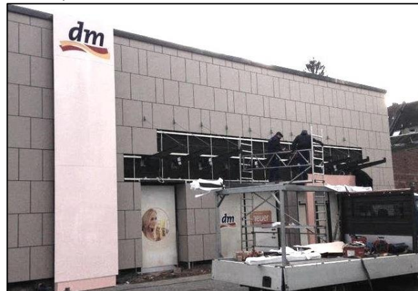
Facadepladerne er monteret i vildt forbandt
